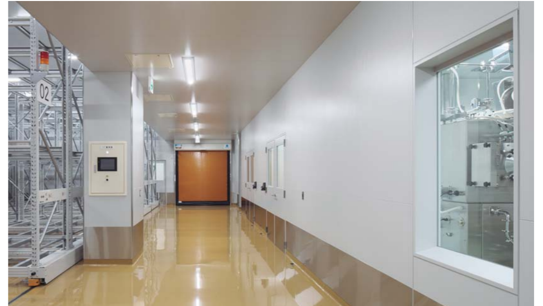
移動棚、サンプリング用グローブボックス(高活性)
