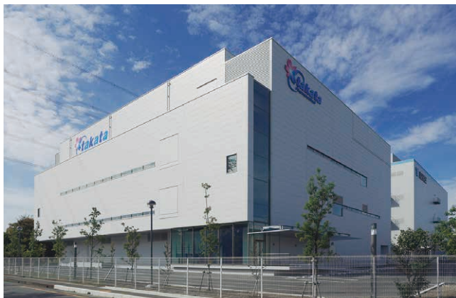
写真1 2024年2月に稼働した北埼玉工場2号棟
