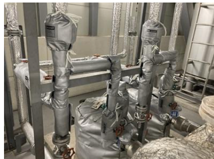
ダクト保温ジャケット取り付け
