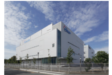
北埼玉工場2号棟外観
