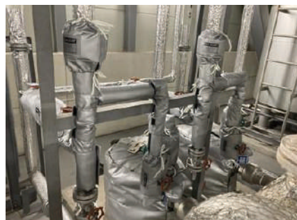
ダクト保温ジャケット取り付け
