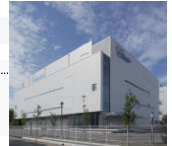
北埼玉工場2号棟
