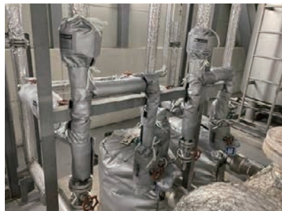
ダクト保温ジャケット取り付け
