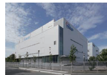
北埼玉工場2号棟外観
