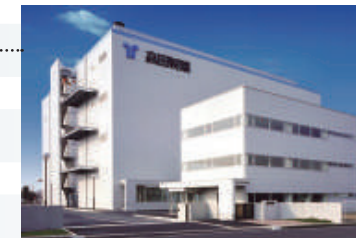
北埼玉工場1号棟
