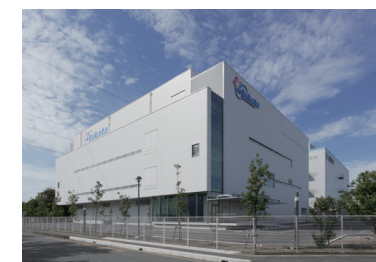
北埼玉工場2号棟外観
