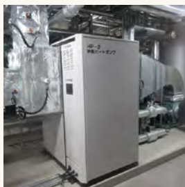
北埼玉工場へ導入した 熱風ヒートポンプ
