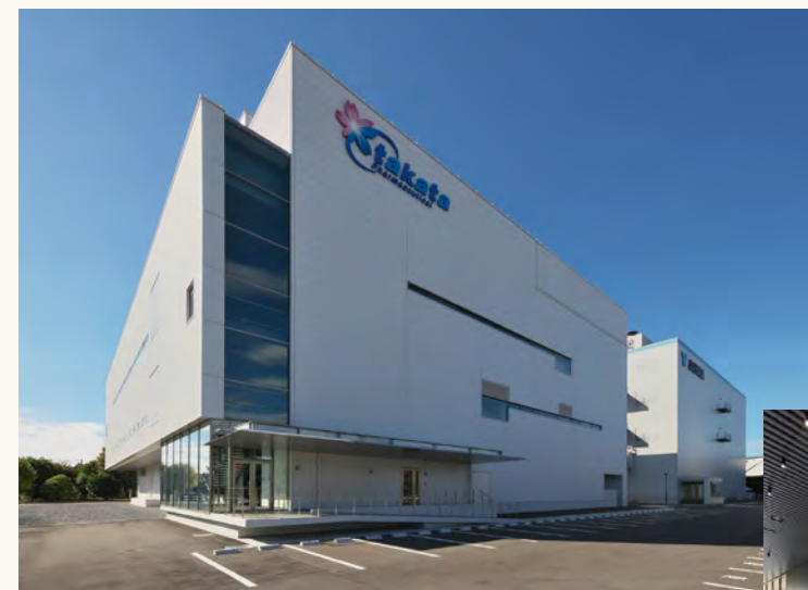
北埼玉工場外観
