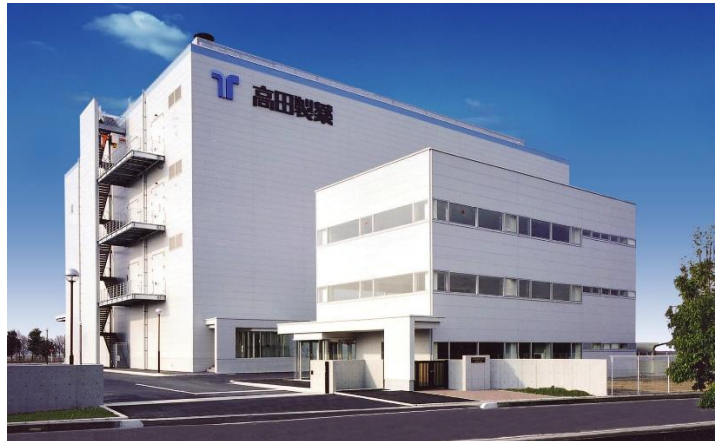
排熱回収・熱風回収ヒートポンプを導入した北埼玉工場
