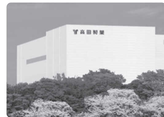
固形剤拠点工場 幸手工場(幸手市)
